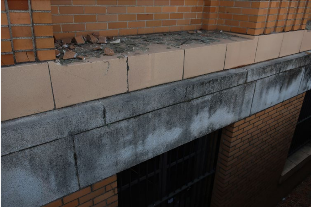
Fig.3 – Granite (and terra cotta) wall base
