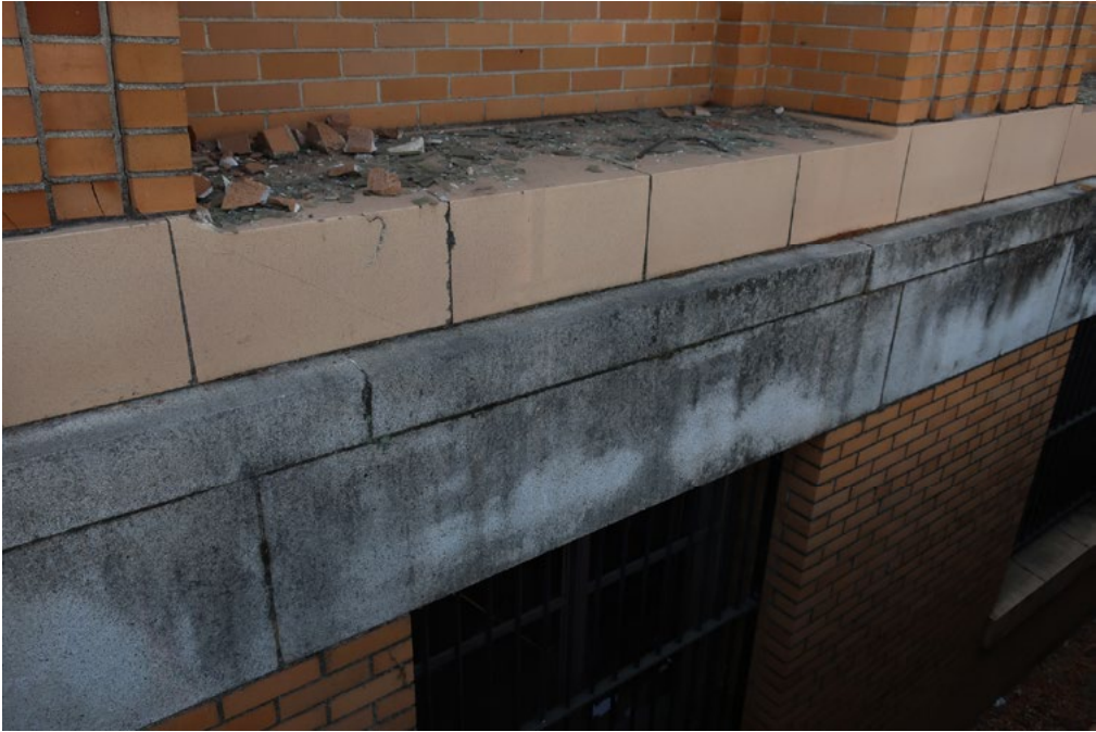
Fig.3 – Granite (and terra cotta) wall base
